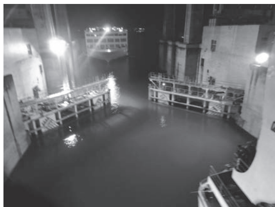
5段階で水位を調節して船舶の航行を行うシップロック（閘門）式の水路
