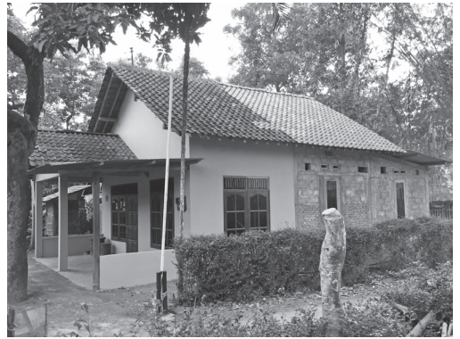
図21 増築されたコア・ハウスの例
