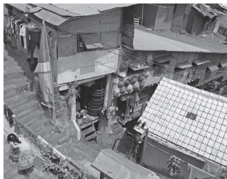
図11 川へ下る階段と竹を使った建物
