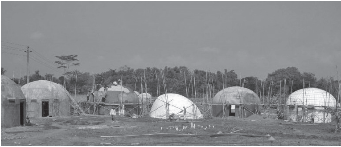
図22 建設中のドーム・ハウス 文13)
