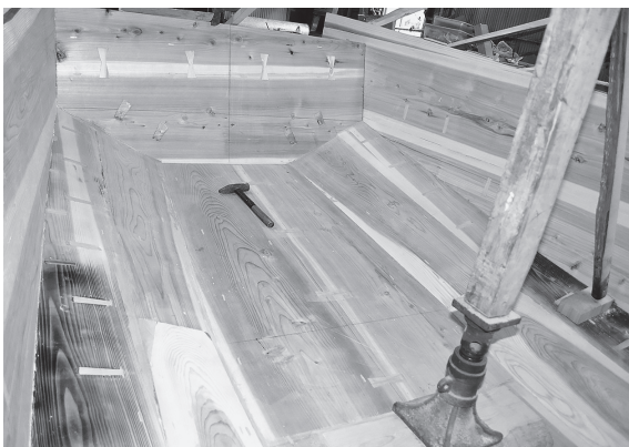
写真 26 テントの戸立と底板のチキリ
