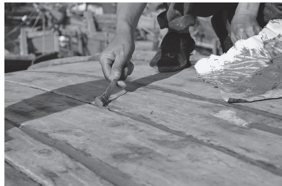
写真41 油灰の充填作業 (福州市連江県)
