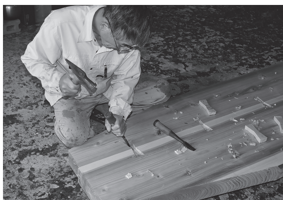
写真 22 角鑿でチキリ穴を彫る
