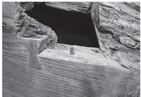
写真 29 破損部から見えるルークギ
