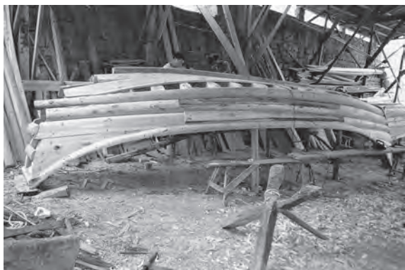
写真 68 裏返して外板材を張り付けていく
