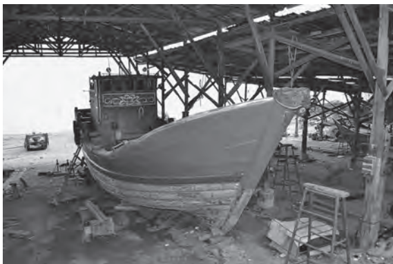
写真 17 修理中の大型漁船（福青沃造船所）
