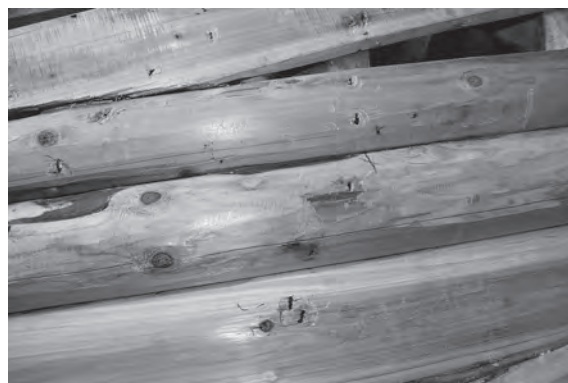
写真 73 打ち込まれた船釘
