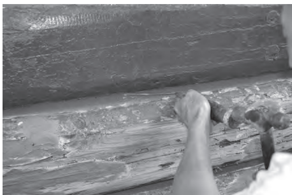
写真 30 油灰に「アーボンディン」を打つ (福青沃造船所)
