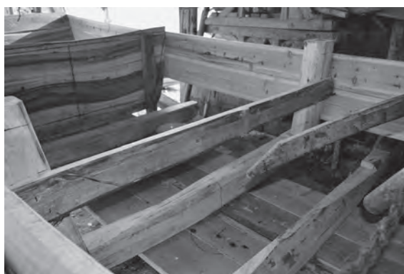
写真 63 縦方向の肋材の取り付け
