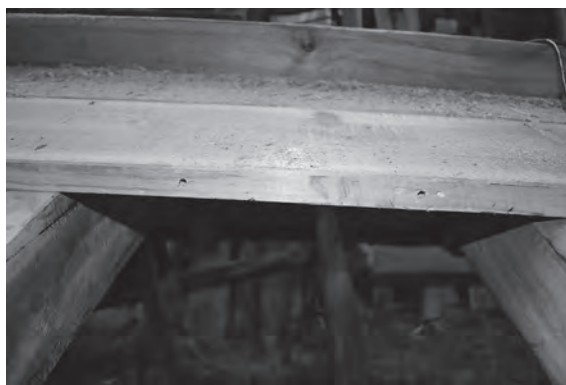
写真 59 船底部材にあけられた釘の下穴
