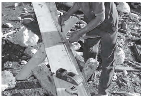
写真 65 船尾反り上がり部の墨付け
