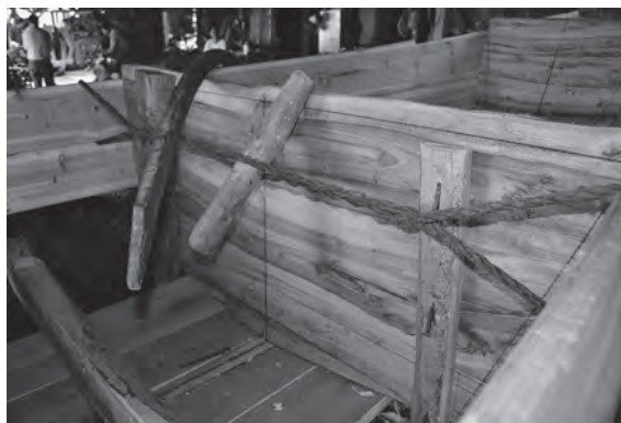
写真 61 舷側部材をロープで固定する
