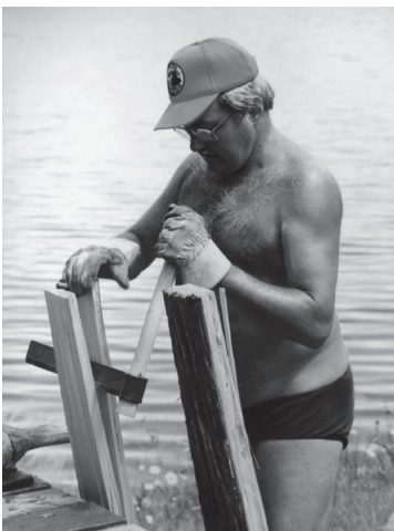
写真 15 割出し鉋を用いて厚さ 5cm 程度の板材に加工
