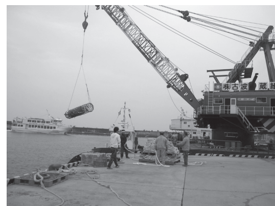
写真 7 伊良部漁協自主製作の表層型パヤオ敷設作業 (宮古島市佐良浜漁港) 撮影: 伊良部漁協
