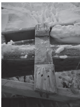
写真79 床材とチェーン、キールの接合部。チェーンと床材は接着剤と結びで接合されている
