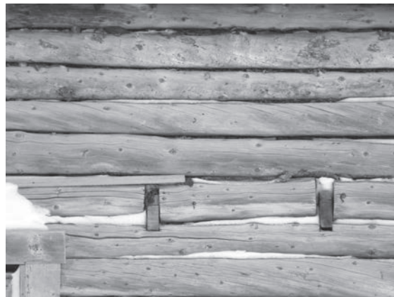
写真58 コッツビュー湾沿いに建つ、古い丸太小屋の外壁。材は唐檜。木目が直伸している材と、捻れている材がある
