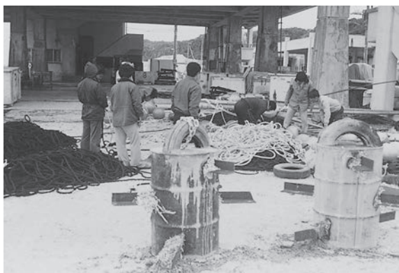
写真 10 ドラム缶にコンクリートを流し込んだアンカー 撮影：宮古島市役所 1985年2月
