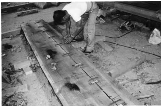
敷材を据える
