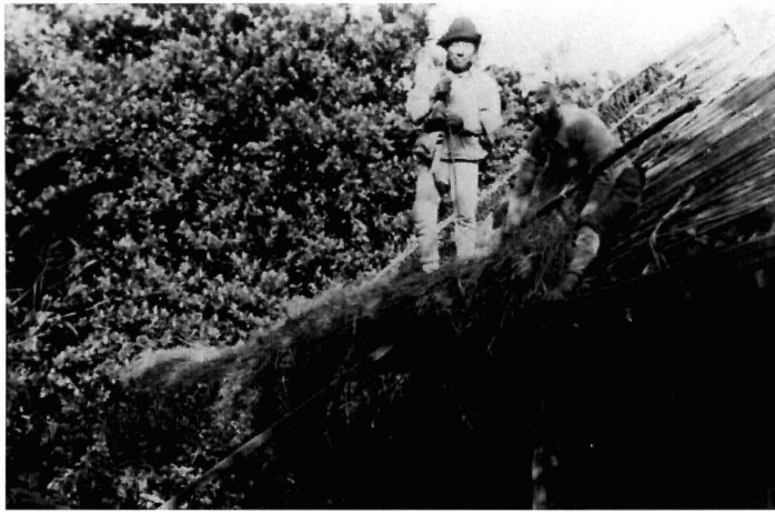
写真204 屋根葺 [目録番号：ア-6-4]
