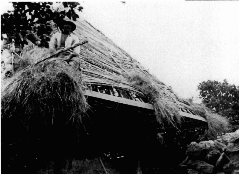
写真203 屋根葺 [目録番号: ア-6-7]
