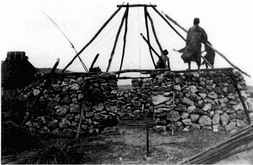
写真198 家立(四) 家屋(4) 棟の 両端にムケーを差し終り隅木を掛けよ うとする処 棟より垂直に下れる縄を 棟取(muni-tui)という [目録番号: ア-6-22]
