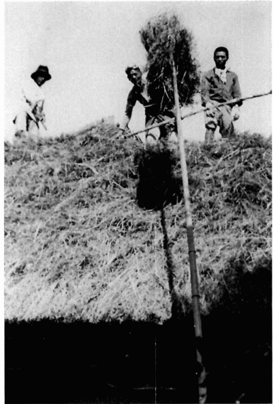
写真205 屋根葺 [目録番号：ア-6-5]
