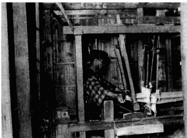
写真5 しめばた 締機 大島紬の原糸に模様をつける為の機 於阿伝 昭11.4 [目録番号：写真類1-14-42]
