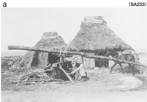
砂糖きびを馬の力で圧搾し、小屋で煮る。この馬を使う圧搾装置を喜界島ではクンマと呼んでいた。
