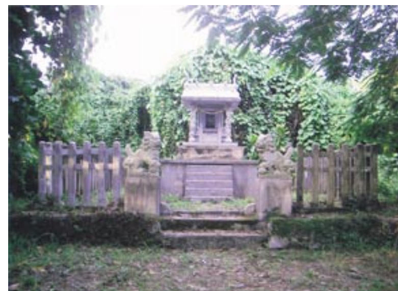
写真17 同前 玉垣、本殿基壇、狛犬は旧住吉神社時代のもの。基壇の上に石造の新しい本殿が置かれている。
