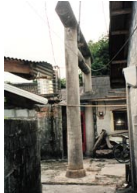
写真4 同前 一の鳥居の片足(柱)は民家の柱のよ うな形になっている。
