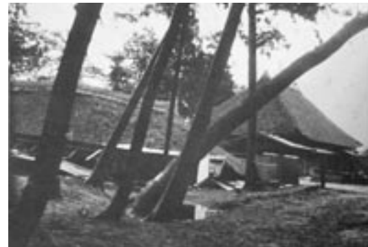
村辺野坂郡川田縣形山(三十) 図20(B13) 図ノ倒顛傾斜ノ木樹屋家ルタリ当ニ線亀裂ノ地
