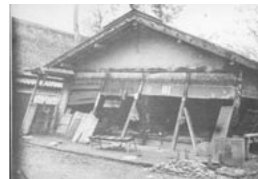
図ノ斜傾大屋家村越砂郡海飽縣形山 (十三) 図 37 (B30)
