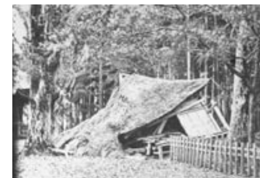
図ノ倒壊社殿内境宮鳥飛郡海飽縣形山(三十三) 図 40(B33)
