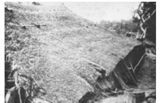
村森黒郡川田西縣形山(六) 図13(B6) ス倒壊テリ当ニ層新ノ此ハ家住ノ戸一及ニ尺八トコルス陥落ノ地生を層断
