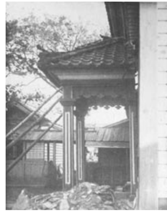
破損ノ口入出面側所役郡海飽町田酒(十二) 図27(B20)
