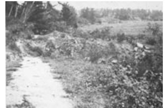
村森黒郡川田西縣形山(四) 図11(B4) ブ及び二間八七トコルス動移ヲ部一ノ路道テシ壊崩腹山
