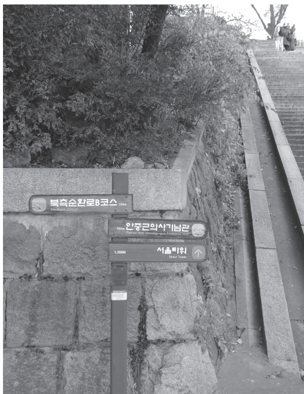
写真 32 北側階段側溝部に玉垣笠石・子柱材が転用されている
