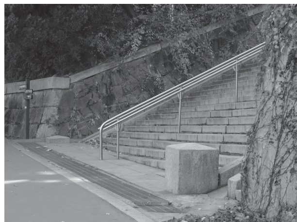
写真 34 北側階段装飾親柱として転用されている親柱材
