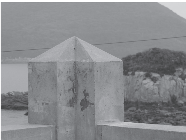
写真 7 石造玉垣ではあり得ない形状で復元された玉垣親柱
