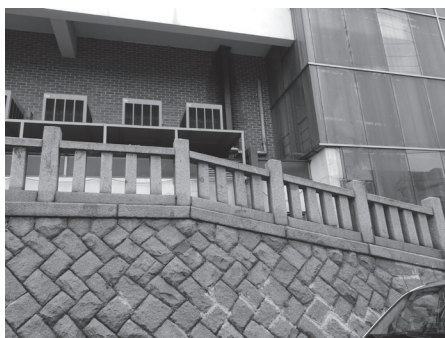
写真 24 仁川神社玉垣および石積擁壁 2
