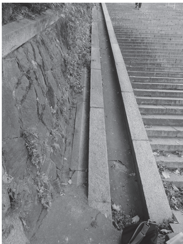
写真 33 北側階段石積天端に玉垣笠石材が転用されている
