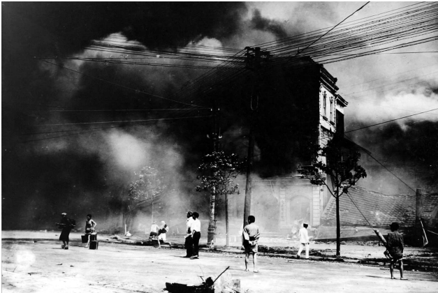
写真10 写真9より少し時間をおいた状況
