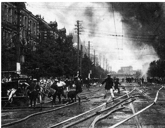
写真4 消防活動中の丸の内
