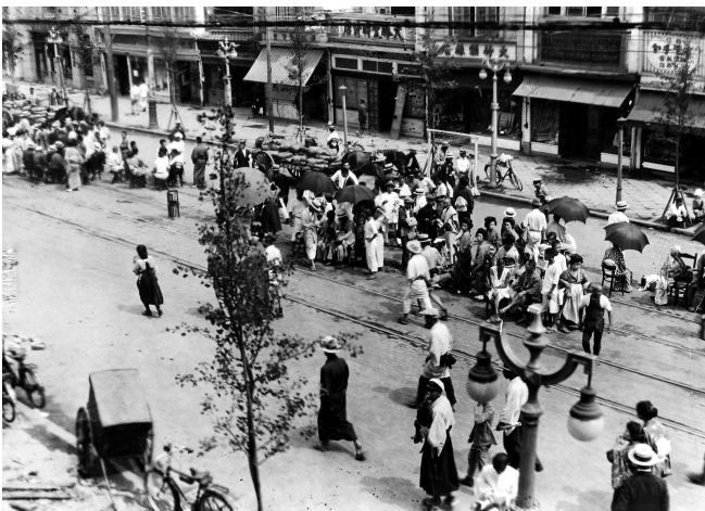
写真12 地震直後の銀座通り
