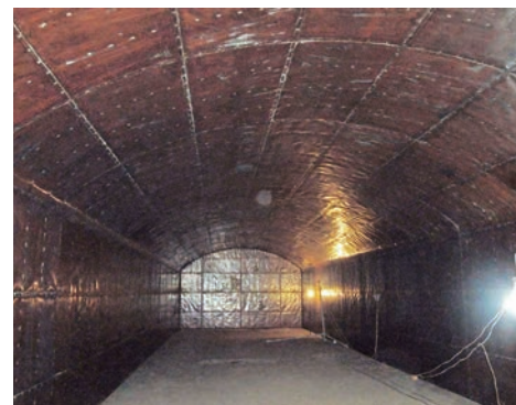
図6 洞窟式火薬庫の内庫内部
