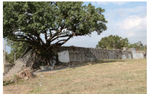
写真3 城壁の一部。写真左側に石段がある
