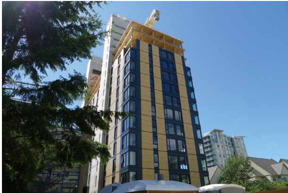
図6 建設中の木造高層建築
