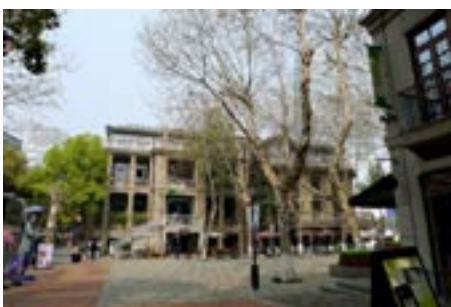
図4 旧民団小学校住宅（現在、ブティックとして再利用されている）
