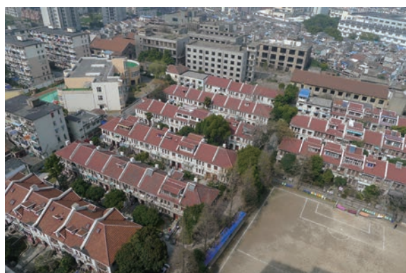
図2 隣接する高層集合住宅屋上より敷地内に現存する住宅群を見下ろす
