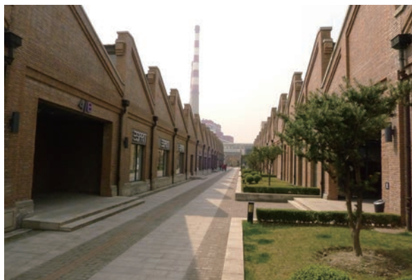
図 3 採光のためのこぎり型となっている屋根
