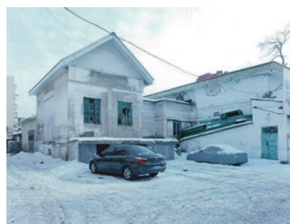
写真 1. 吉林神社跡。神社建物がそのまま使われている。正面の拝殿跡と思われる建物の中はゴミ置き場？となっていた。
