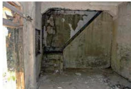
写真2 新化社地下神殿の内部。正面の階段は元の社務所につながる。一方、左側は崖に口を開いた開口部である。壁・天井を仕上げていた漆喰はほとんど剥落しているが、壁・天井境の入隅を回縁代わりに装飾的に塗り廻したコーブなどに一部漆喰が残っている。
