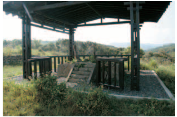
写真 7 基壇保存状態
