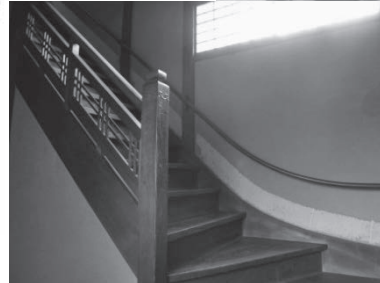
←写真11 裏階段 (撮影日： 2015.3.26)
