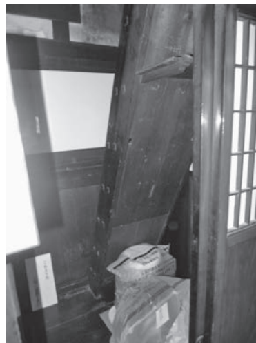
写真3 裏階段(撮影日:2014.12.18)
