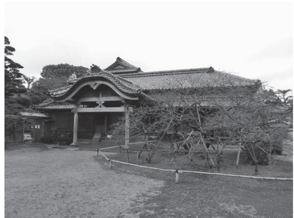
写真17 旧鍋島家住宅（撮影日：2015.1.22）
