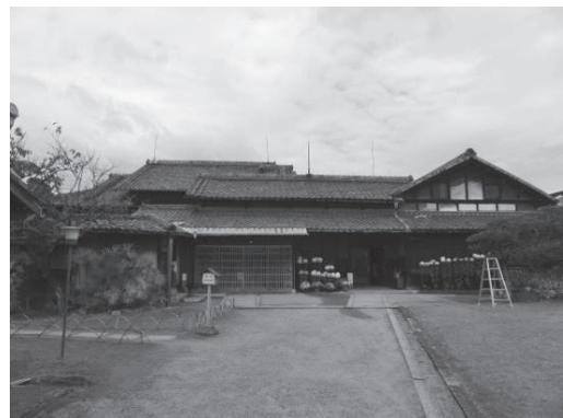
写真4 旧西尾家住宅(撮影日:2014.11.19)
