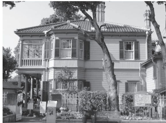
写真 21 小林家住宅 (撮影日：2015. 3. 17)
