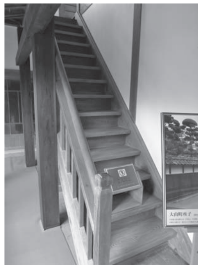
写真 19 裏階段 (撮影日: 2015. 1. 22)
