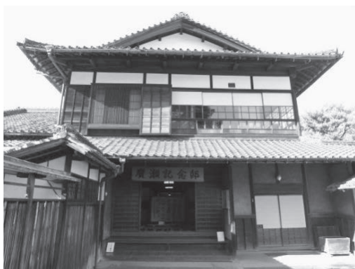
写真6 旧広瀬家住宅（撮影日：2014.12.27）
