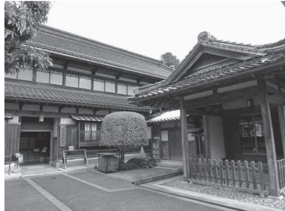
写真14 石谷家住宅（撮影日：2014.12.26）
