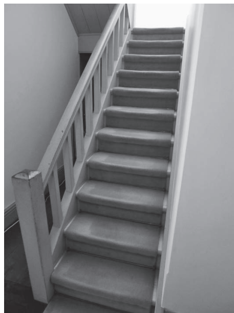
写真28 裏階段 (撮影日: 2014. 12. 19)
