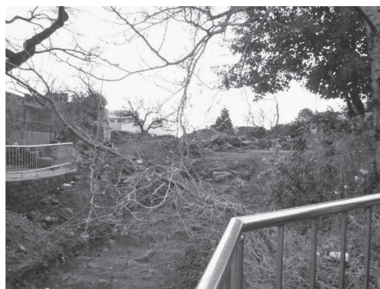
写真 2 気象庁新築工事現場 2014 年 2 月 7 日 渡邊奈津子 撮影
