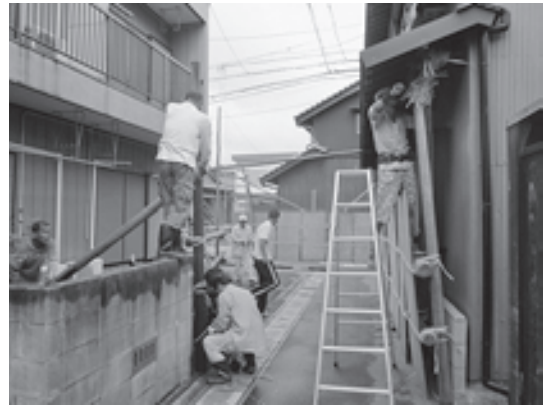
写真12 民家に柵を設ける
