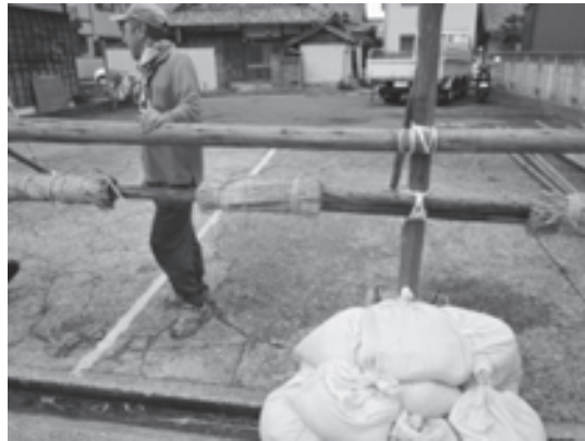
写真11 道路に防護用の柵を設ける
