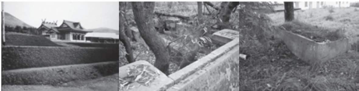
写真 14 旧樺太護国神社 (豊原市大字豊原) と、そのコンクリートの基壇と石造の手水鉢
