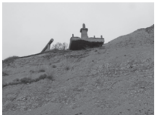
写真8 「戦勝記念碑」が建っていた土手の法面は浸食されて危険な状態となっていた。
