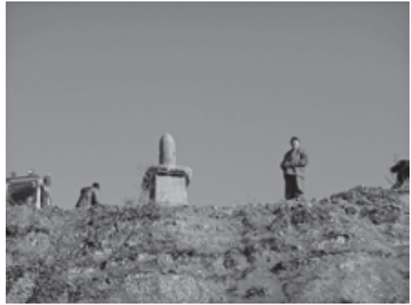
写真10 復旧工事中の泊居神社の「戦勝記念碑」2011年撮影
