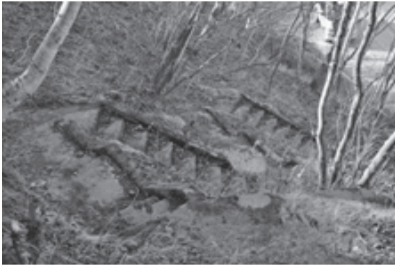
写真 30 水天宮 コンクリートの階段
