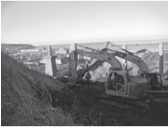
写真9 復旧工事中の泊居神社の「戦勝記念碑」 2011年撮影
