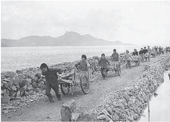
写真2 「三八海塘」を建造している様子
