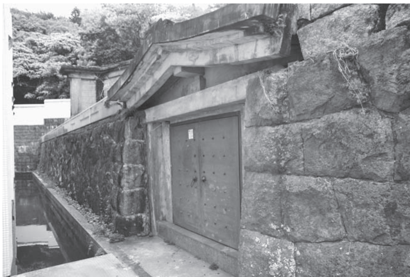
写真3 地下遺構の入口。後方に西筋塀の端部が見える。
