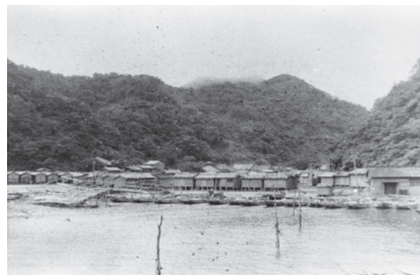
図 10 宮本写真、中央手前から右奥にかけて点々と海中より突き出た木がスイカである。左端の海に突き出して造られた柵状の構築物が網棚である。
