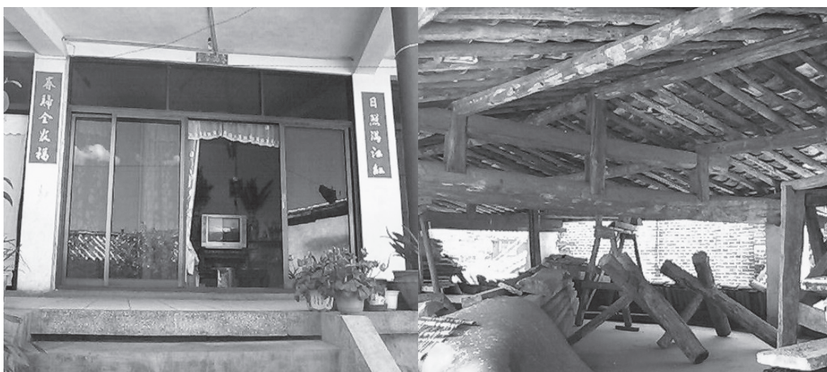
写真8 コンクリート造りの建物と景観を保護するためにその屋上に設置された瓦屋根
