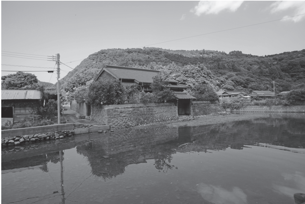
写真3 石垣塀で囲み、志多留川に面して船用の門を石垣塀に開く旧給人の屋敷。
