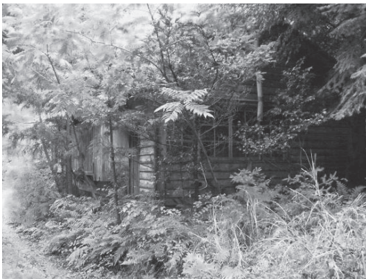
写真3 営林署の旧造林合宿所
