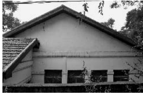
現況写真 8-⑥ 旧拝殿妻面。 桁上端に垂木の痕跡が残る。元入母屋造であったことが確認できる。
