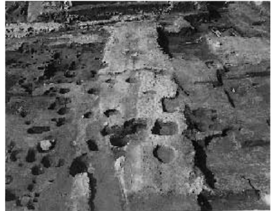
図28 土丹で舗装された鎌倉時代の道路跡（河野 1993）
