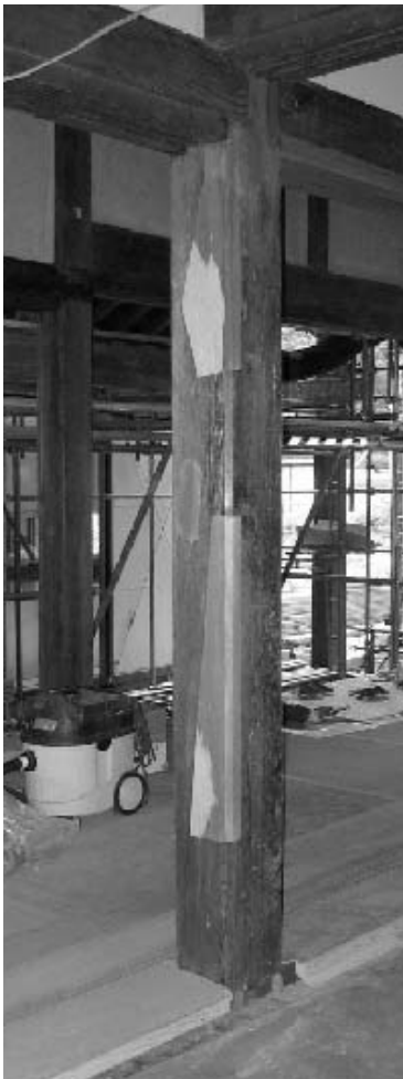
図11 埋木〔横浜市西方寺修理工事の場合、白っぽく見えるのが埋木〕
