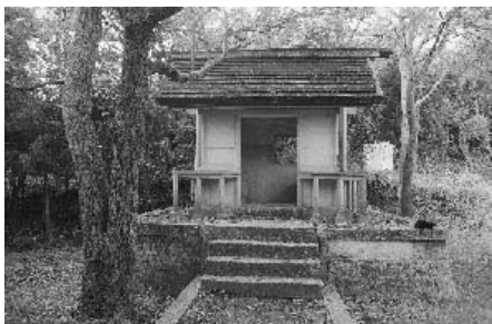
5-④ 小鹿島神社，神殿正面。屋根はスレート葺。
