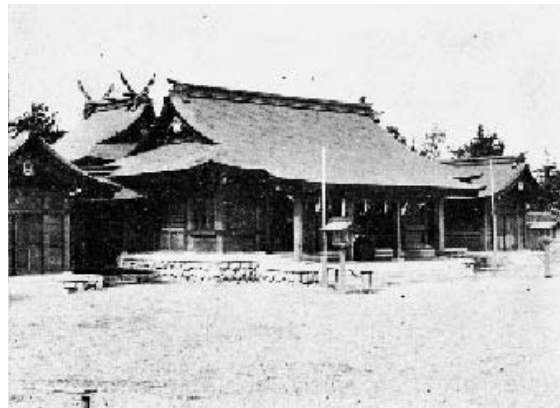
1-④光州神社神殿・拝殿・祭器庫・神饌所全景，（『朝鮮と建築』第21輯第9号から転載）
