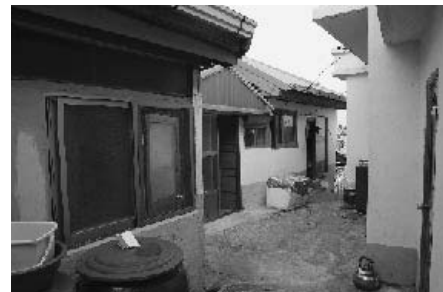
2-⑤松島神社，旧社務所外観．左の建物が旧社務所である．外観は改装が甚だしくかつての面影はない．
