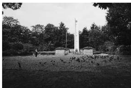
1-⑥光州神社，社殿のテラス。正面慰霊碑が建てられている付近に拝殿・その奥一段高くなったところに本殿，それらを幣殿つないで複合社殿を構成していた。さらに横長の拝殿両脇に祭器所・神饌所を伸ばしていた。
