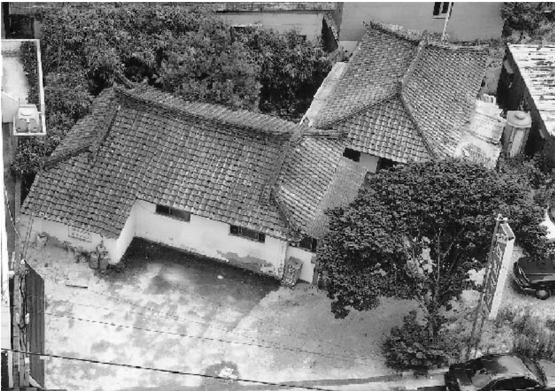
写真11 旧達里駅付近の古民家 (2005. 8.17筆者撮影)
