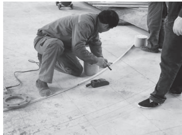
写真3 舟山市普陀岑氏作坊原図場での型取り作業
