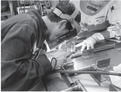
図20 フレーム製作の様子 (溶接作業)
