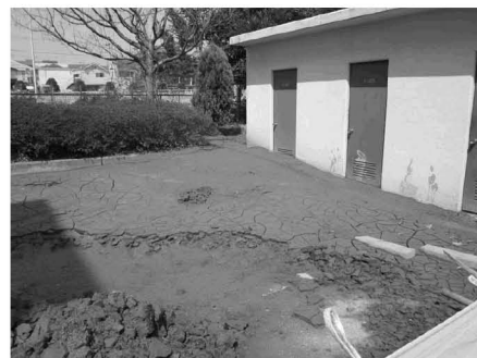
写真6 噴砂で埋まった倉庫 高洲
