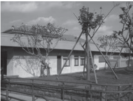
写真6 外壁がうすい黄赤色の建物（同公園にて）
