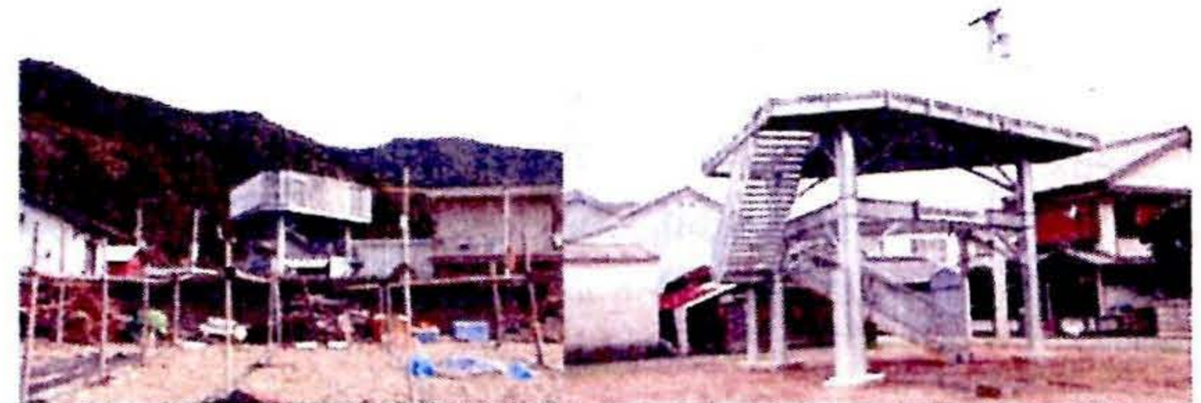
写真-1 美波町の津波避難タワー
