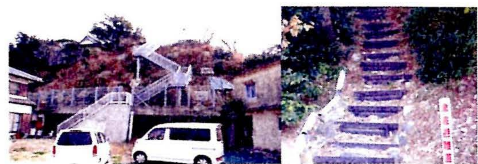
写真-2 美波町由岐地区に設置された津波避難階段
