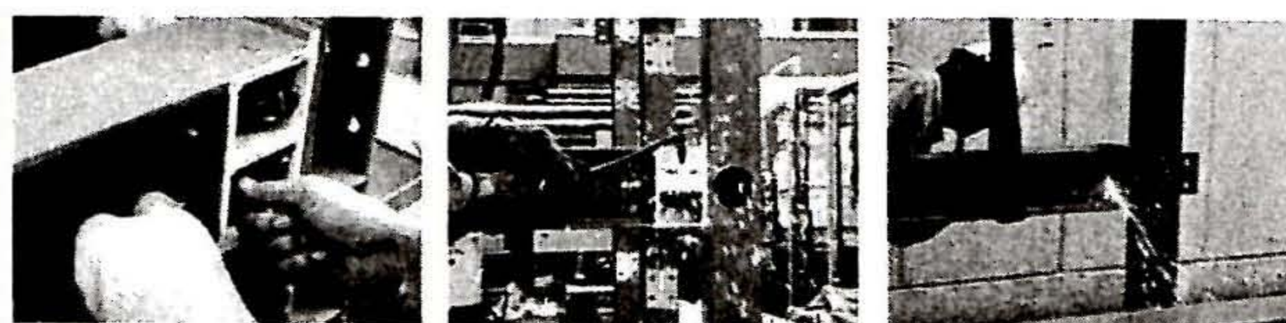
(a) ボルト逆回し (b) 鋼棒溶断 (c) 母材溶断 写真4 SBS 梁解体方法
