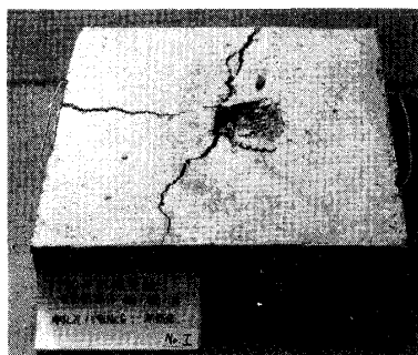
写真-9. 破壊状況タイプ3
