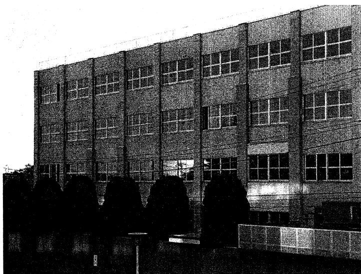
図3-9 改修前の建物写真
