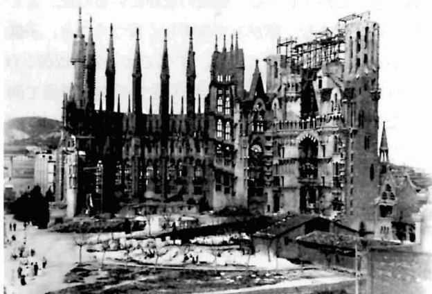
図7 サグラダ・ファミリア聖堂、建設状況 1906年
