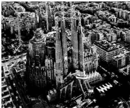
図1 サグラダ・ファミリア聖堂、2010年建設状況
