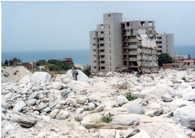
写真 7.1 扇状地での被害例（松田撮影） ベネズエラの 1995 年の土石流災害
