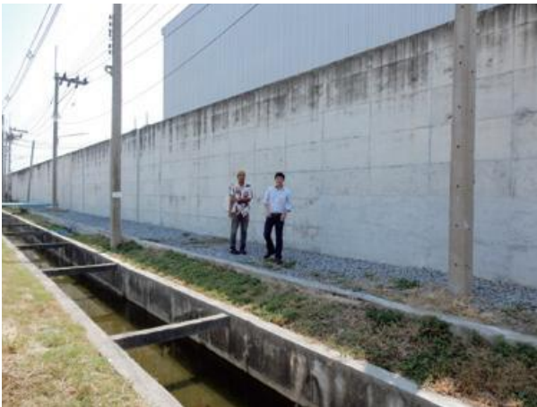
写真2. 工業団地内の工場の遮水壁と排水路
