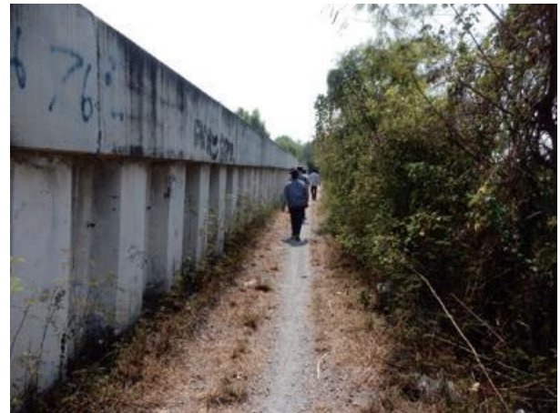
写真3. 工業団地を囲む輪中堤と遮水壁
